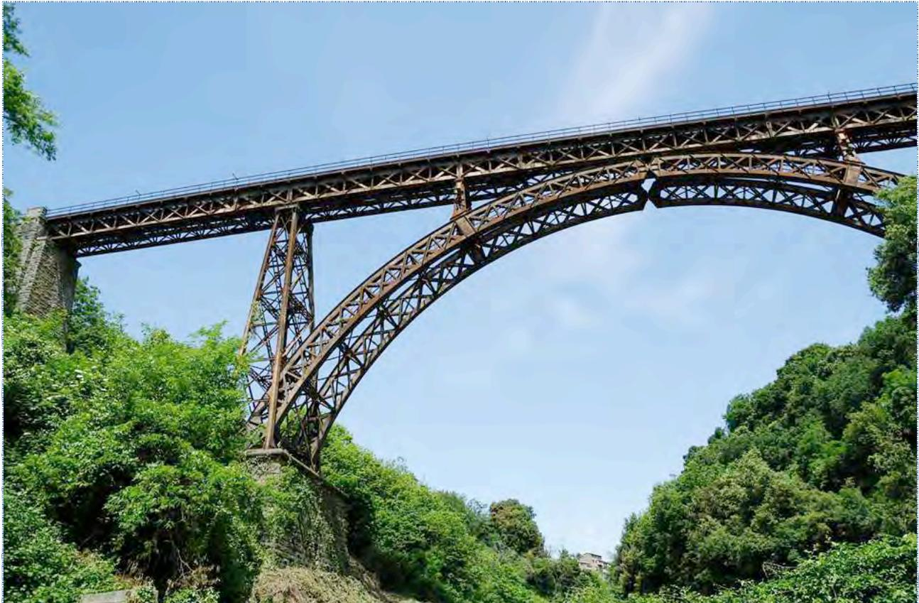
Il Ponte di Ronciglione, come analoghi ponti e grossi tralicci dell'epoca<sup>2</sup>, è interamente chiodato con rivetti fissati a caldo, anche perché nell'epoca della sua realizzazione la tecnica della saldatura richiedeva impianti poco pratici da impiegare in quelle condizioni di intervento. Gli strumenti portatili per la saldatura, in particolare quelli a elettrodi, si erano cominciati a diffondere solo all'inizio degli anni venti.
