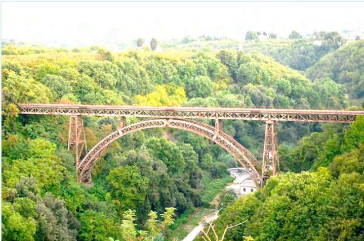
Il ponte fa parte della linea ferroviaria Civitavecchia Orte, progettata nel 1921, in funzione fino al 1994, serviva per il superamento del Rio Vicano. Si tratta di un pregevole esemplare di carpenteria metallica di derivazione tecnologica ottocentesca, realizzato nel 1928 dalla Società Nazionale Officine di Savigliano, che nel 1888 aveva costruito un analogo ponte sull'Adda, di dimensioni maggiori.
