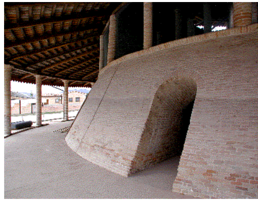
Serra de' Conti (AN) Fornace Hoffmann - Portico del forno - 2000 - foto di Paolo Brugè
