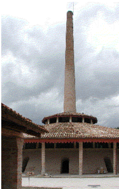
Serra de' Conti (AN) - Fornace Hoffmann - veduta d'insieme del forno - 2000 foto di Paolo Brugè
