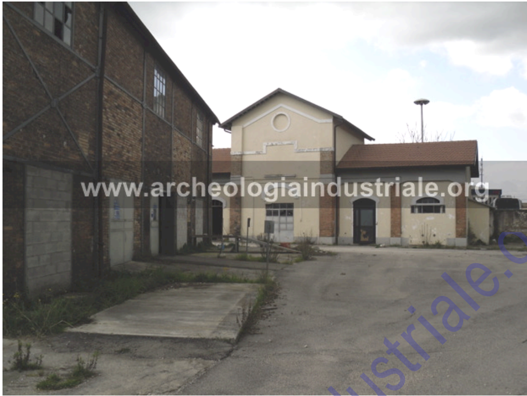
Nelle foto precedenti, l'area del gasometro di Terni oggi.
